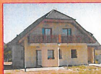
Novostavba RD Ostrava - Plesná
