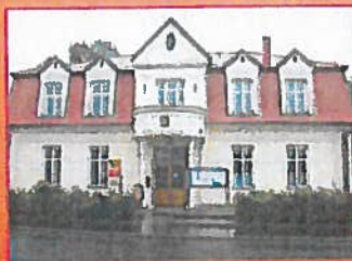
Rekonstrukce OÚ Nošovice
